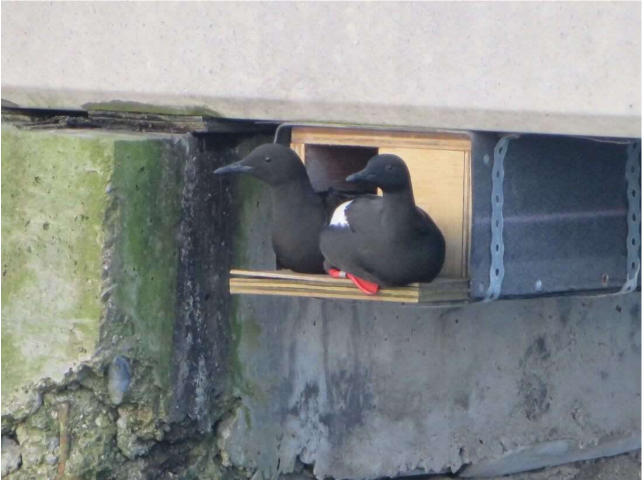
Figur 8-2. Eksempel på rugekasse for teist som er montert under kai/brygge. Foto: Dublin Port.
